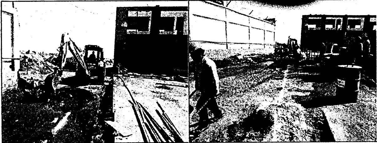
Foto N° 01 y 02: Trabajos realizados en patio de maniobra escavacion mediante retroexcavadora.
